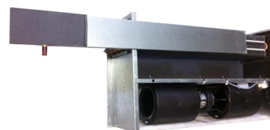
Extraire le bac condensats métallique par le côté ou par le dessous
