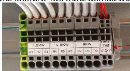
Bornier pour les limiteurs de température
