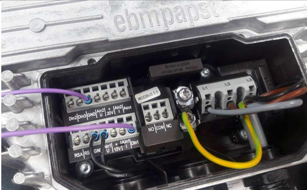
Signal (externe) 0-10V de commande branchée sur Ain1U et GND
