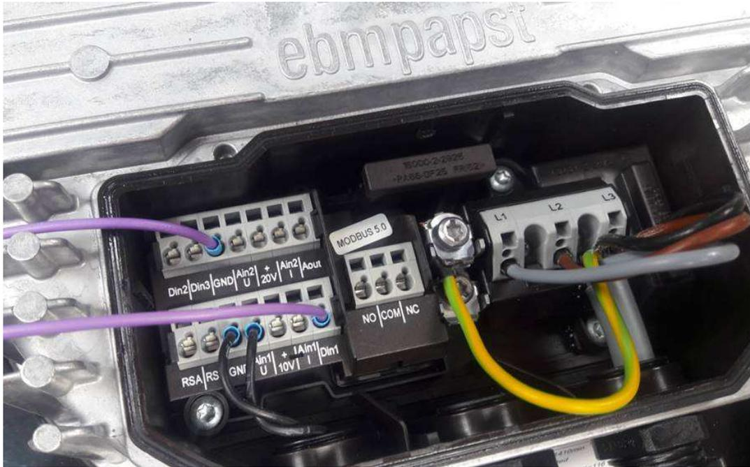
Signal (externe) 0-10V de commande branchée sur Ain1U et GND
