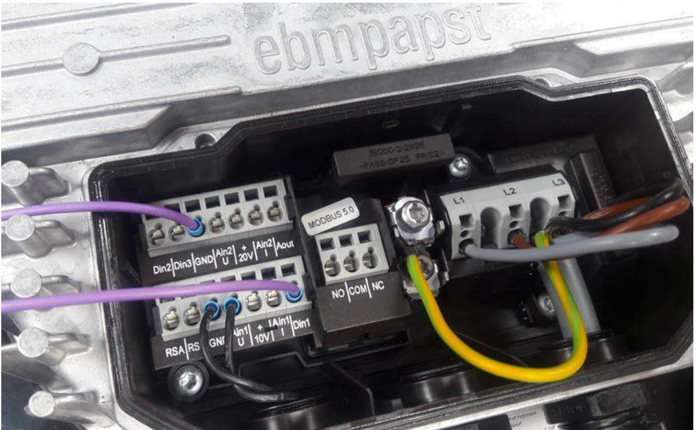
Signal (externe) 0-10V de commande branché sur **Ain1U** et **GND**
