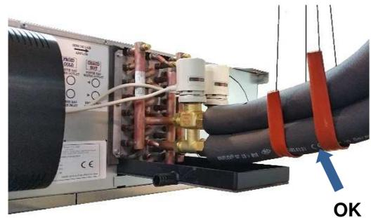
• Lorsque les raccords sont terminés, il est nécessaire d'entourer les vannes et tuyauteries de matériaux imperméables tel que le polyéthylène ou moltoprène expansé d'une épaisseur de 5 à 10 mm.
